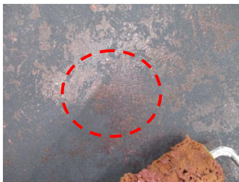
写真3. 海綿ローラーでかきとった後 (ローラーにJC-95があまりついていない状態で転がして、樹脂を少しかきとる)
