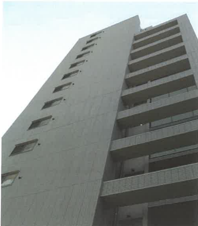
ノルデンハイム天満橋新築工事(大阪市) 押し出し成形板(ECP)・プレキャストコンクリート(PC)
