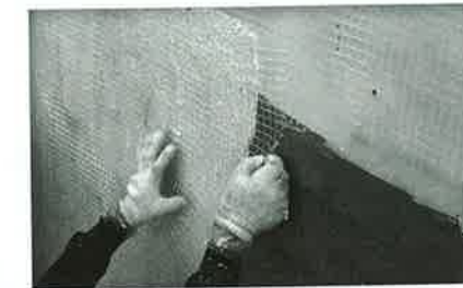
図4のポリマーセメントモルタルの代わりに、アクリル樹脂を用いて施工した。追従性や防水性に優れるが、施工単価はポリマーセメントモルタルより高い(写真と資料:コンステック)
