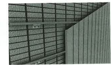
〔写真7〕金属板でタイル外壁を覆う 既存のタイル張り仕上げをアルミスパンドレルで覆った改修事例(写真:理研軽金属工業)
