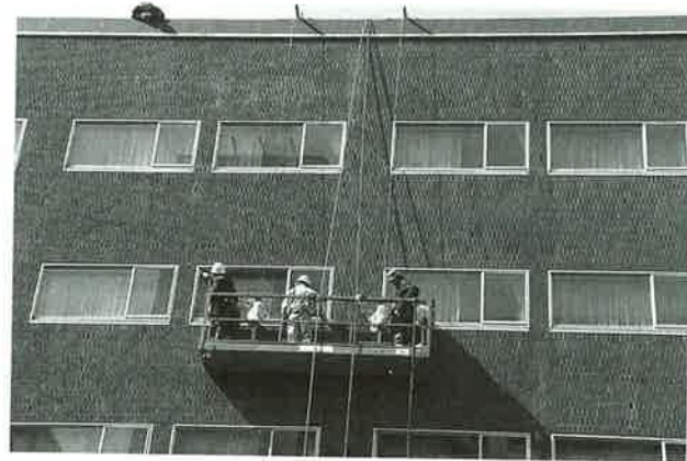
〔写真1〕ゴンドラを用いた打診調査 屋上から吊るしたゴンドラに乗った技術者が、テストハンマーでタイルをたたき、その打撃音から浮きの有無を判断する(写真:109ページまで特記以外はコンステック)
