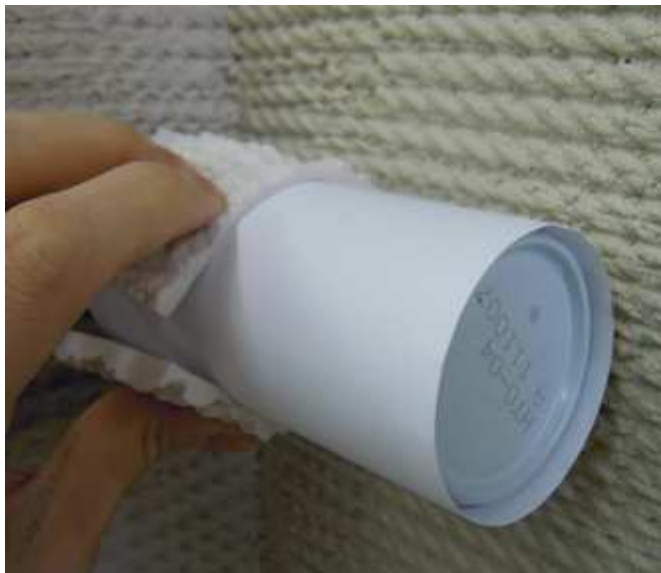
写真 入隅シートの使用例 (写真はイメージです)
